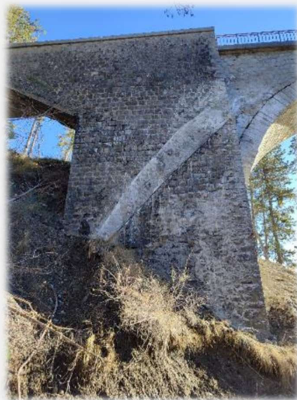
Pile-culée après travaux d'urgence
